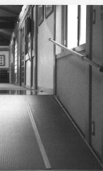
本堂へ続く階段に設置したスロープ。その脇には、住職自ら取り付けた手摺りや、お年寄りの歩行にも配慮されている
