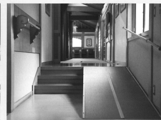
玄関に設置した簡易スロープ。床が傷つかないようゴムを挟んでいる
